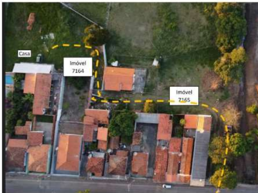
Imagem aérea 2026 - Trajetória de acesso destacado pela linha tracejada
